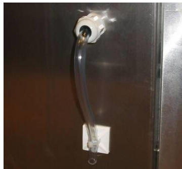
Figur 5. Montering av tryckslang för mätning av atmosfärstrycket.
