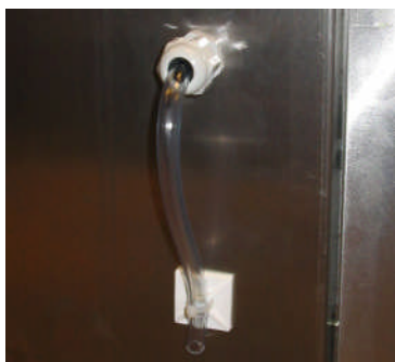
Figur 5. Montering av tryckslang för mätning av atmosfärstrycket.
