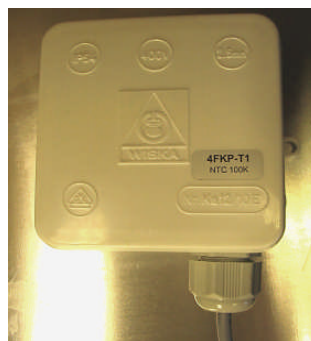
Figur 6. Temperaturgivare 4FKP-T1.
