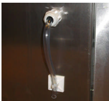
Figur 5. Montering av tryckslang för mätning av atmosfärstrycket.
